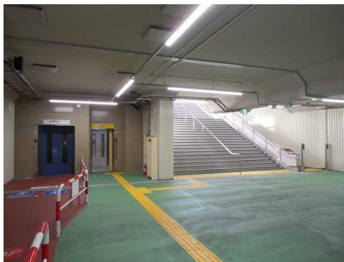
竹ノ塚駅地下自由通路
